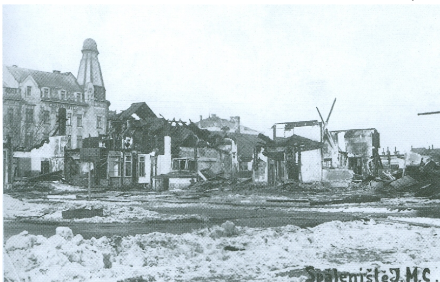
Obrázek 2. Spáleniště budovy YMCA České Budějovice po Vánocích 1923. 17
